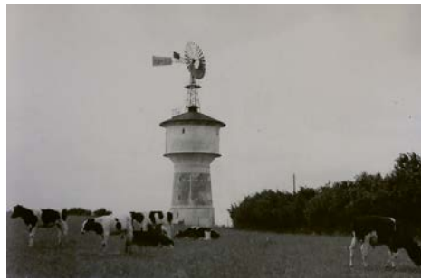
Abb. 2: Der Windmotor der Firma Köster versorgte um 1910 die 2000 Einwohner:innen von Klein-Niendorf in Norddeutschland mit Wasser.
