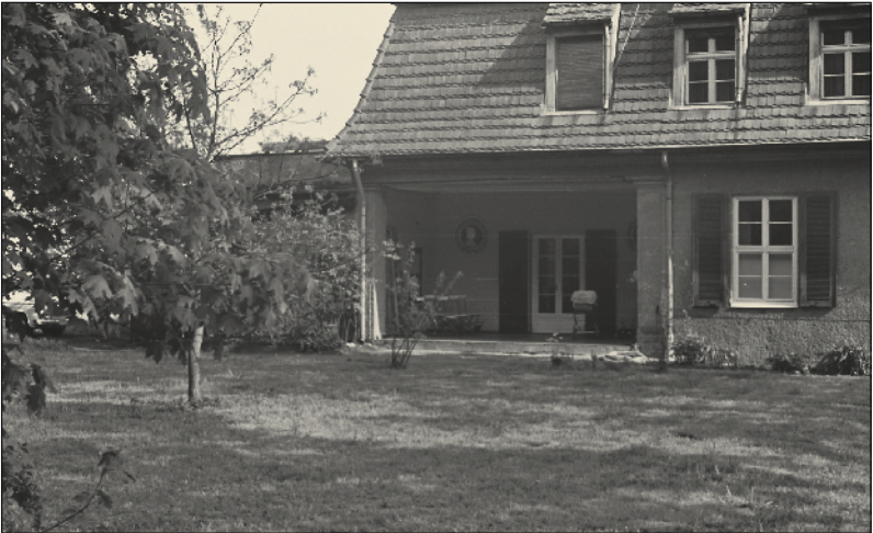
Die Loggia auf der Gartenseite (1977)
